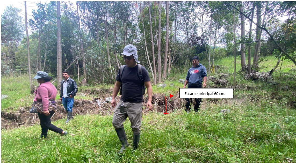
Ilustración 6: Movimiento de ladera ML2, donde se puede observar un escarpe principal mayor a 50 cm, con una amplitud aproximada de hasta 80 metros.
