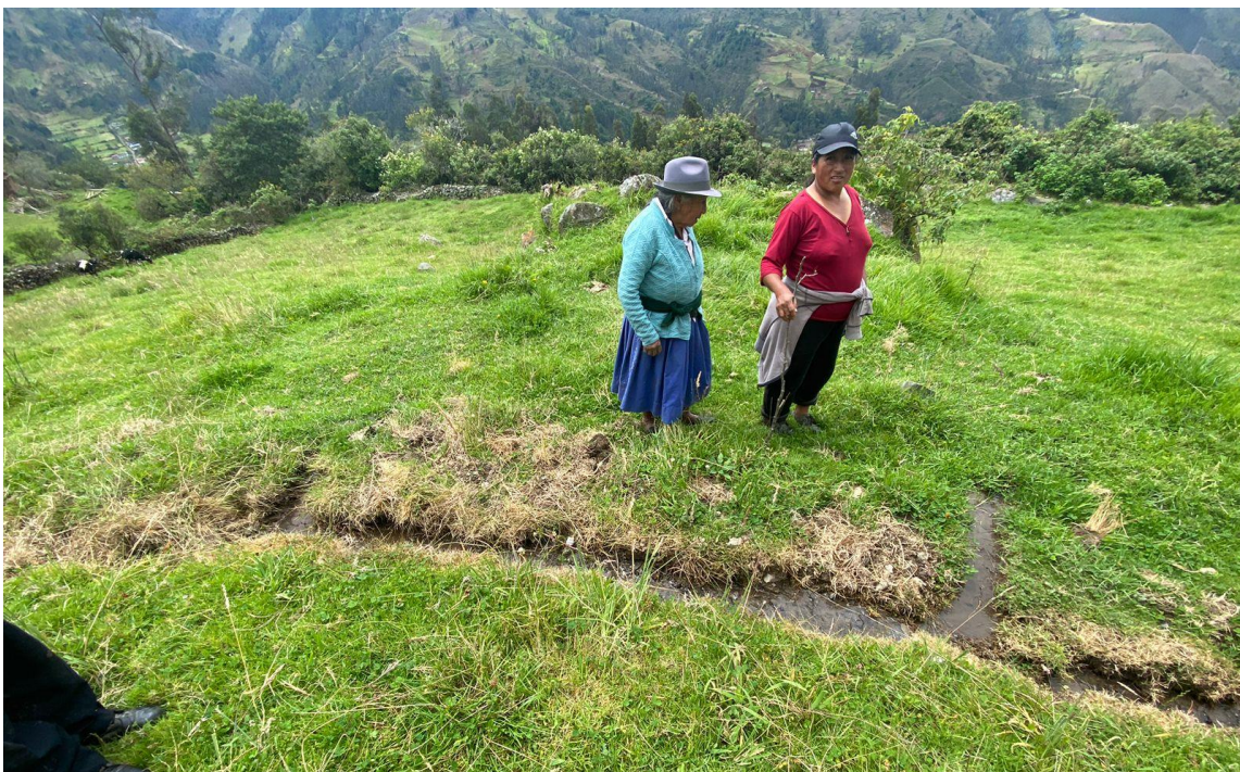
Ilustración 4: Izq. Zanjas realizadas para recanalización del agua y regadío de los pastizales lo que efectivamente es una de las desencadenantes que mayor influencia tienen para que se genere la inestabilidad de las laderas.
