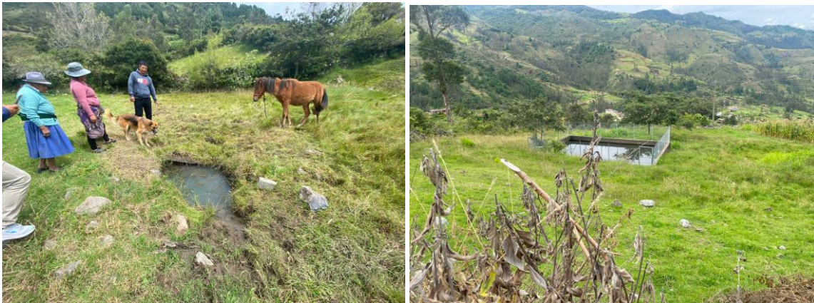
Ilustración 3: Izq.: Reservorio antitécnico realizado sin las debidas precauciones para prevenir infiltración al suelo. Der.: Tanques de agua para almacenamiento, los mismos que se encuentran filtrando agua a la ladera.
