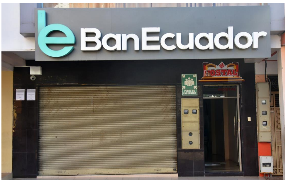
Fotografía 1. Edificio Ban Ecuador Catamayo
