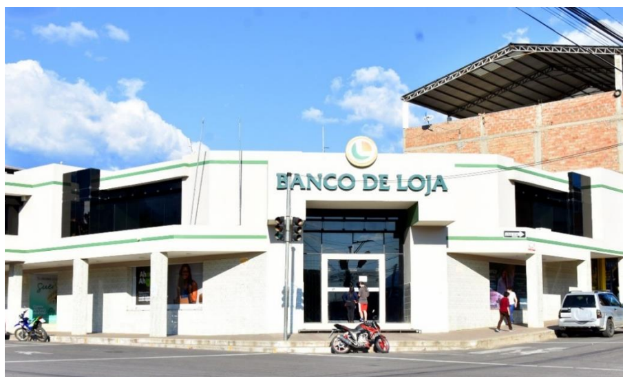
Fotografía 2. Edificio Banco de Loja
